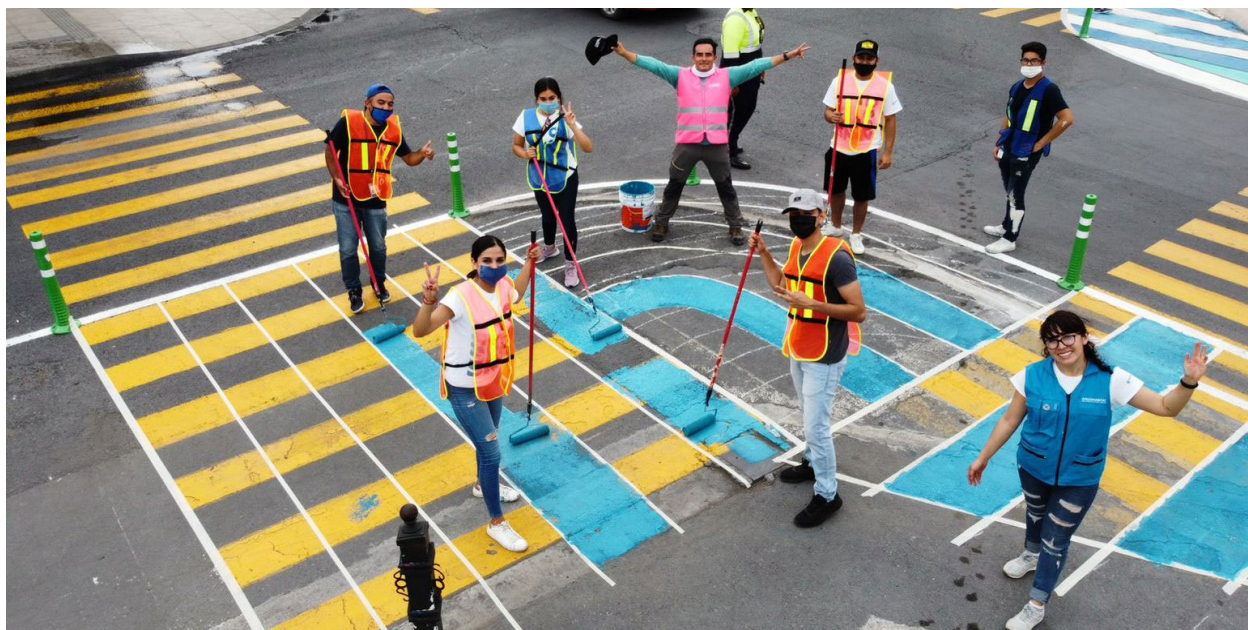
Intervención de urbanismo táctico. Monterrey, México [ONU-Habitat]
